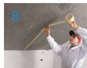
8 vsi spoji, preboji in priključki na foliji morajo biti izvedeni tesno in zalapljeni
