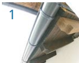
1 v kapu moramo omogočiti dotok zraka v streho
