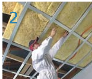
postavimo prvi sloj izolacije
