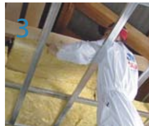
postavimo drugi sloj izolacije
