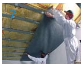
7 na C profil z dvostransko lepilnim trakom nalepimo parno oviro
