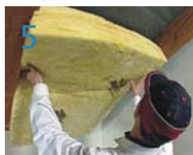
5 odrezano ploščo izolacije vstavimo med špirovce
