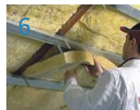
6 na špirovce pritrdimo kovinska obešala in C profil, nato vstavimo drugi sloj izolacije
