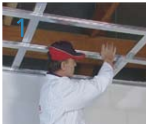
postavimo kovinsko konstrukcijo
